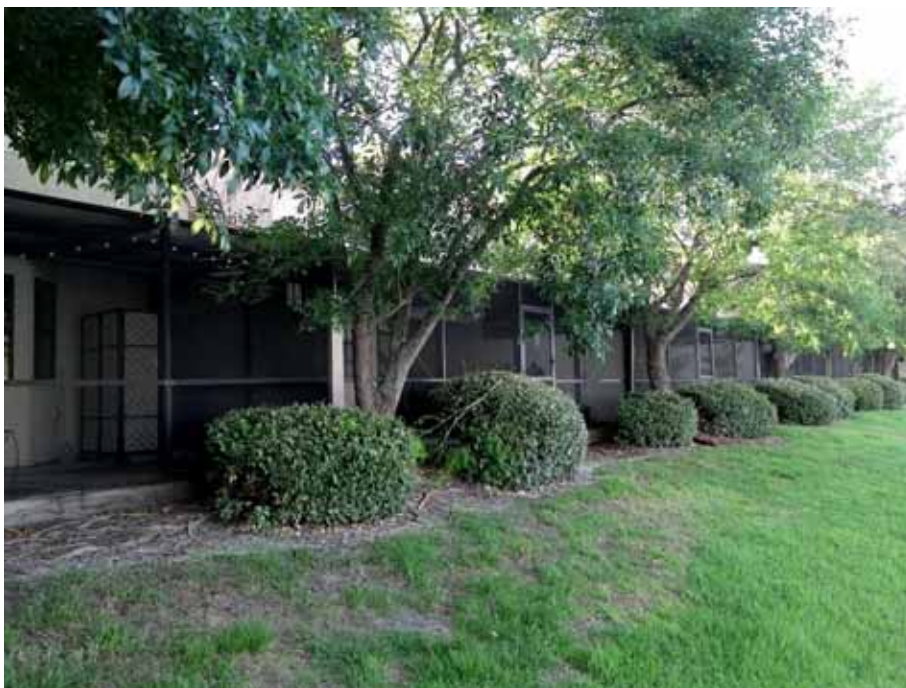
10436-10454 St. Tropez Pl (Condo Bldg, 10 Units)
