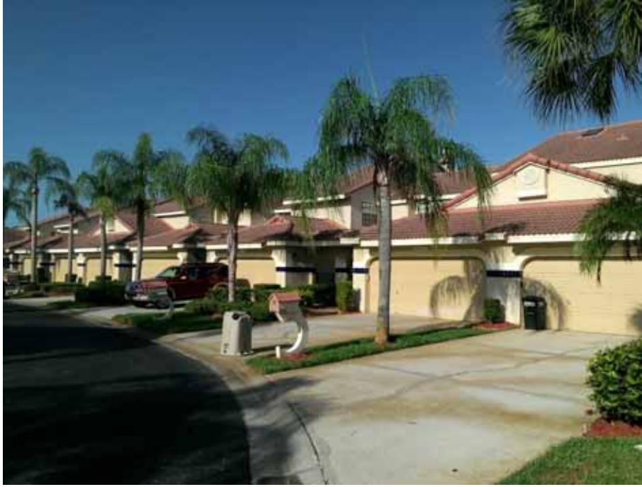
10436-10454 St. Tropez Pl (Condo Bldg, 10 Units)
